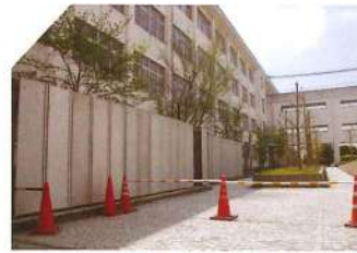
4 月現在、校舎は耐震工事中
