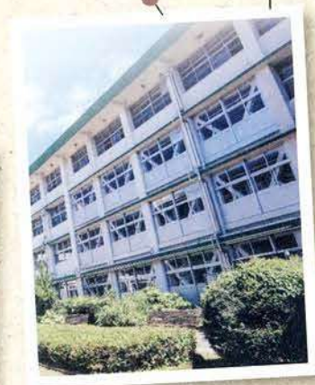
耐震化工事の頃
